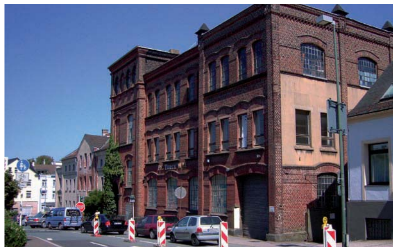
Abb. 35: Firma P.C. Turck, Altenaer Straße (eigenes Foto)
