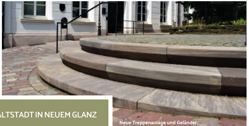
Neue Treppenanlage und Geländer
