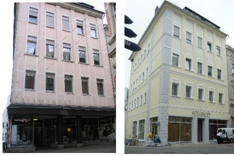
Beispiel: Vor und nach der Sanierung, Gestalterische Aufwertung der Fassade, Erd- und Obergeschoss aufeinander abgestimmt.
